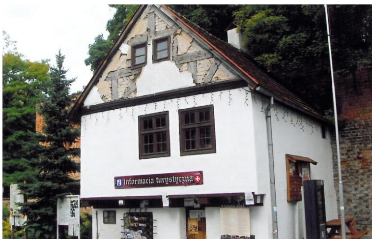
To już 3 lata zaniedbania
